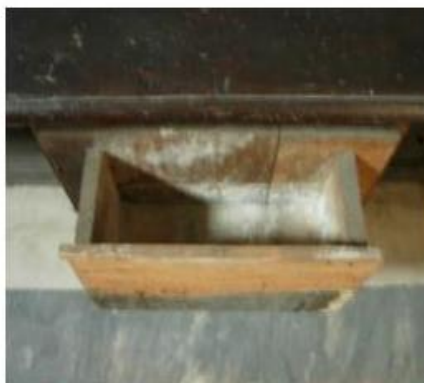
Foto 80 Vano contenitore di un "sogroto" con presenza di muffa e funghi cariogeni del tipo carie bianca
