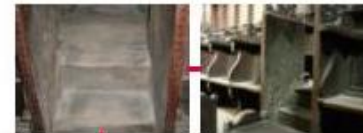
Frasione per usura (cause antropiche)
