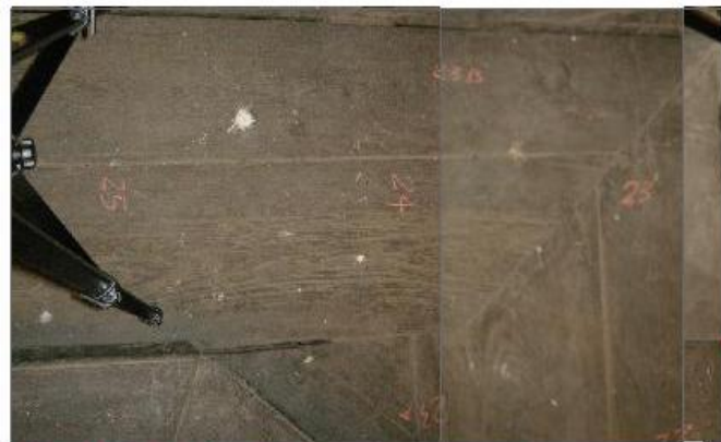
43 - 44 - 45 - 46 Particolare de l'angolo de lavoro de a predelle e de l'ingozzato, realizzato con ass di circa 2,50 m in legno di castagno.
