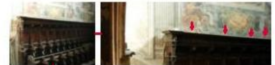
Deformazione (fenomeno dell'imbarcamento)
