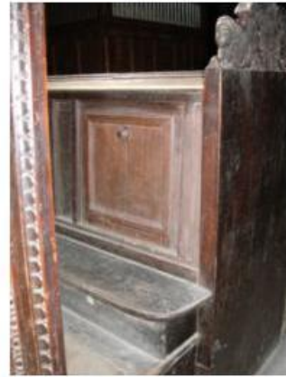
67 "Segno" a tutta in legno di pino domestico a noce lignocornata o in legno di castagno
