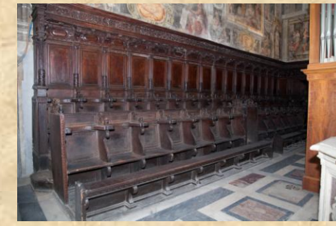
Deformazione (fenomeno dell'imbarcamento)
