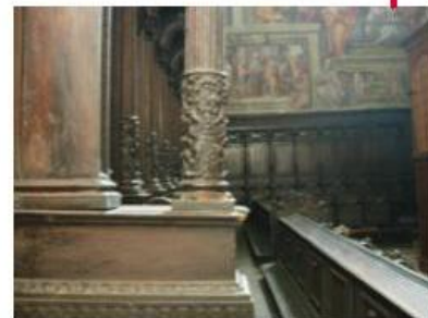
3 Particolare della base intagliata della colonnina e prospettiva del rango superiore
