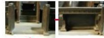
Sgretolamento causato da funghicariogeni*
