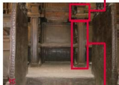
15 Stallo ligneo principale a quota 50 cm dal piano di calpestio
