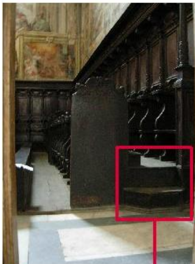
30 Prospettiva dei ranghi degli stalli lignei del primo ordine al piano di calpestio e di quelli superiori, posti a quota 50 cm dal piano di calpestio. Lato sud.sud-ovest e ovest in pianta.
