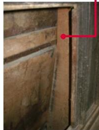
70 Particolare del "segno" a tutta in legno di castagno che sorreggono l'area di "predella"
