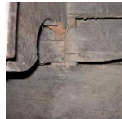
Foto 81 Fenomeno dello sgretolamento
